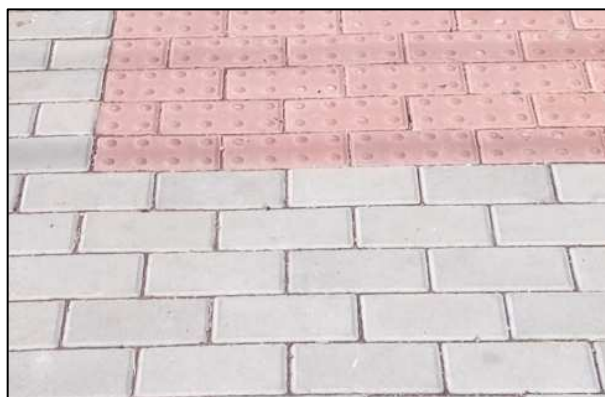
Obr. 2 – Doporučený typ betonové dlažby a dlažby s reliéfní úpravou
